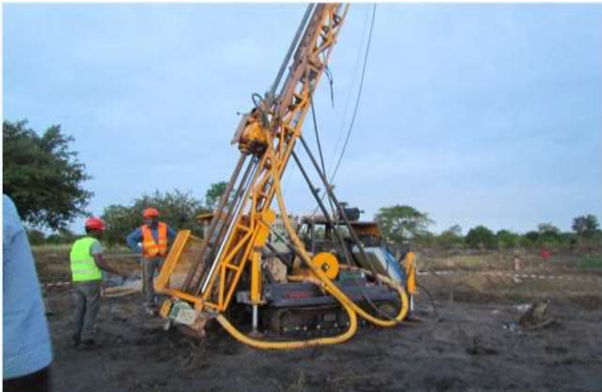
Picha Na.6: Uchorongaji kwa njia ya Diamond Drilling (DD) ukiendelea katika eneo la Itumbi - Chunya
